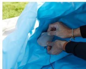
6. Prenez le soin de placer les disques obturateurs de manière à ce que les ficelles soient dirigées vers le bas afin de faciliter l'extraction des disques une fois le bassin en eau. Vérifiez la solidité des nœuds.
