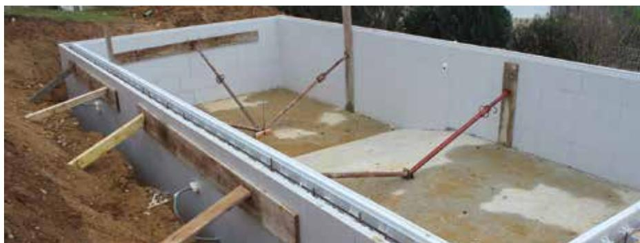
Dans le cas de béton livré par centrale (toupie), il faut également caler les murs par l'intérieur, à l'aide de planches verticales placées tous les 2 m environ. Ces planches serviront également à régler la verticalité du mur et les alignements. Vérifiez les diagonales une dernière fois et ajustez au besoin.
